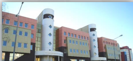
Политехнический институт, г. Мирный
